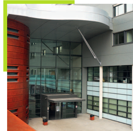
Le CMCM fera l'objet de travaux d'extension très prochainement dans l'ensemble de ses secteurs.
