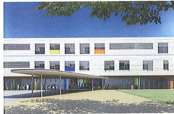
Entrée du bâtiment
